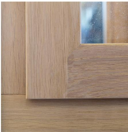
Zu den Spezialitäten von Wehrle gehört eine Konstruktion mit geschlossener Brüstungsfuge ...
