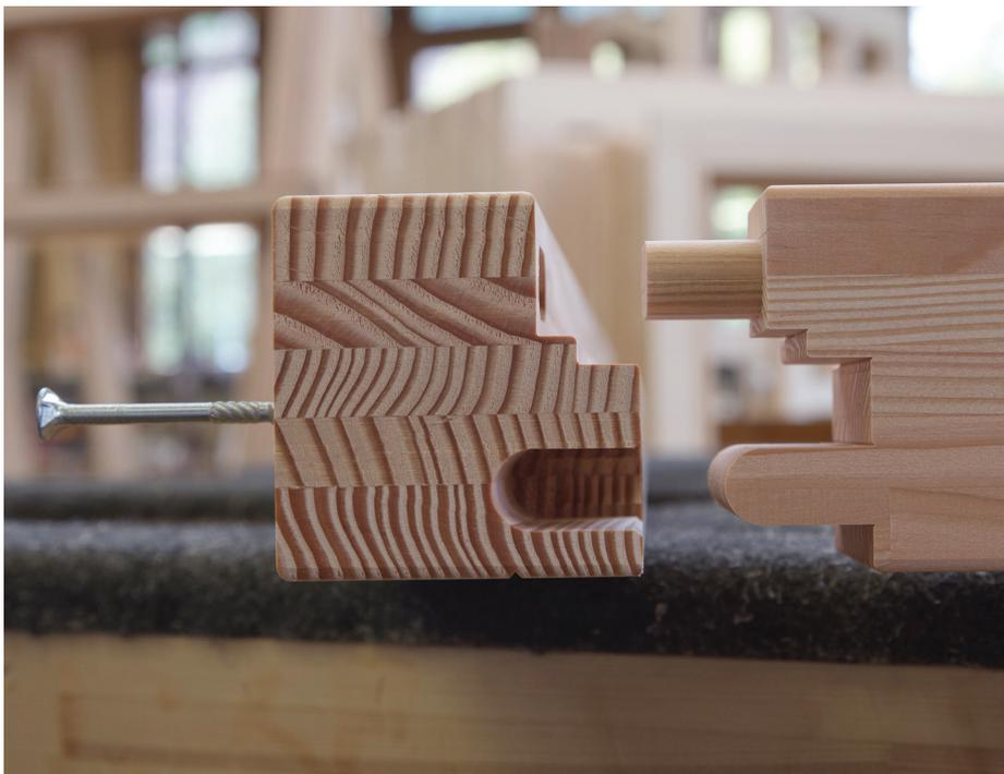
Charakteristisch für die Eckverbindung mit der Bezeichnung „Prüller-Ecke“ sind groß dimensionierte, angefräste Zapfen. Die Rahmen werden mit Schrauben zusammengezogen, so dass eine Rahmenpresse überflüssig wird.
